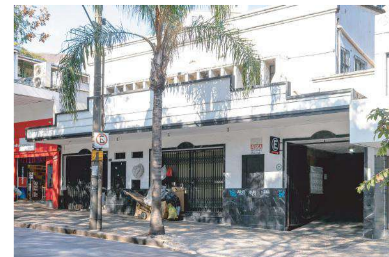
Situação atual da Fachada Principal.
